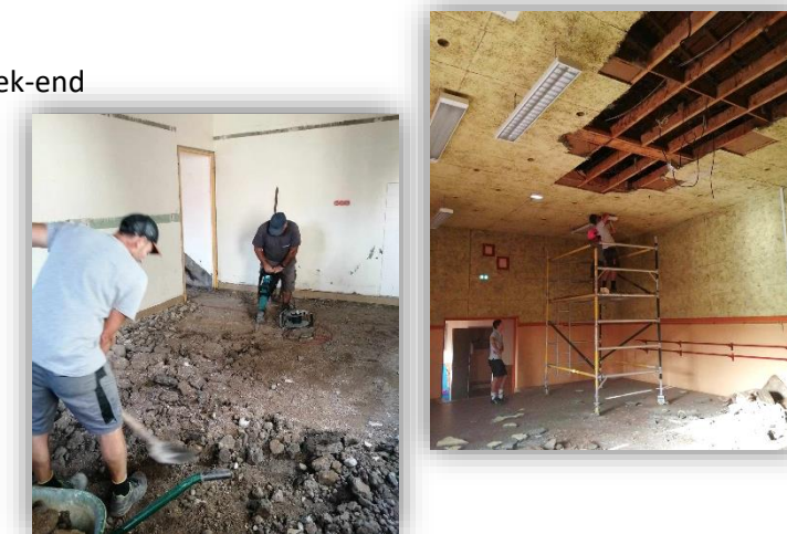
Les travaux préparatoires ont été réalisés par les agents communaux
