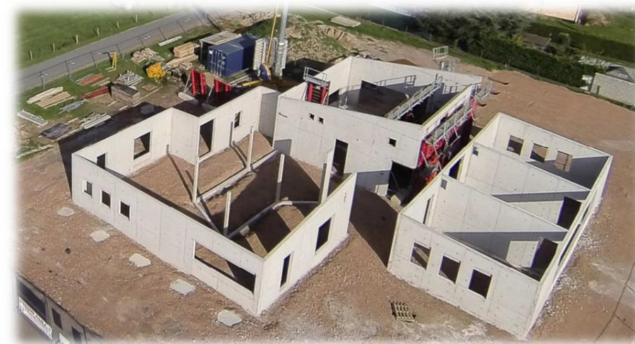
Les travaux de la nouvelle école se poursuivent, conformément au planning prévisionnel établi par notre architecte. Les travaux de maçonnerie sont achevés. La couverture est en cours de réalisation.
